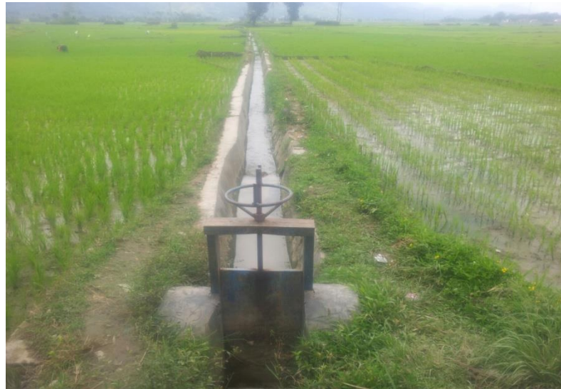
Gambar 3.1. Gambar pintu air saluran tersier. (Sumber:Devi, 2013)
