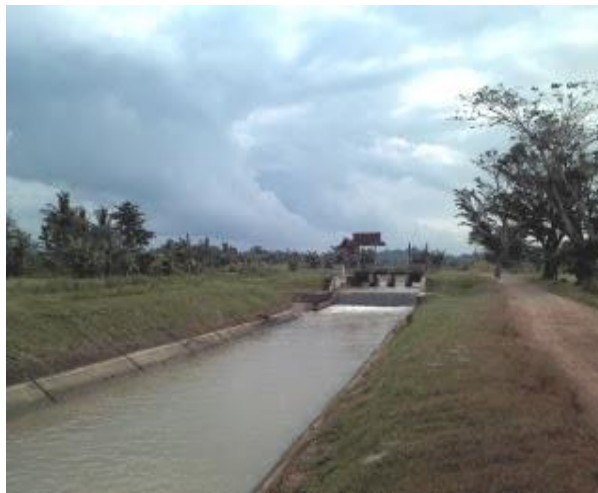
Gambar 2.1. Contoh Saluran irigasi Primer (Sumber : Wirawan, 1991)
