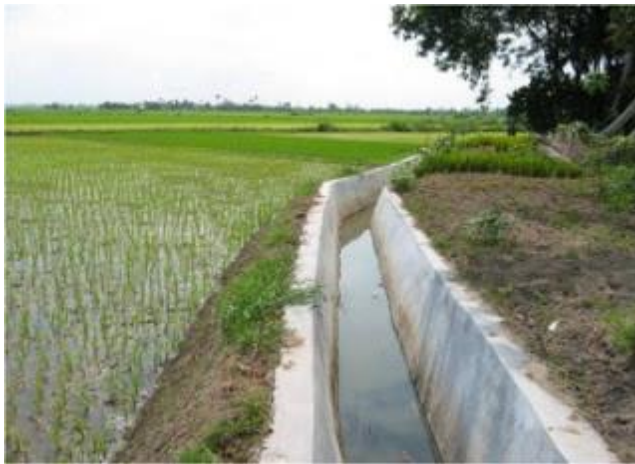
Gambar 2.2. Contoh Saluran irigasi Sekunder/Tersier (Sumber: Wirawan, 1991)
