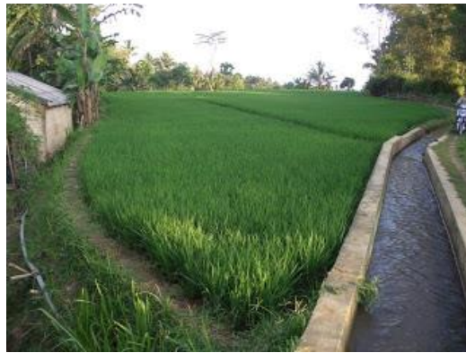
Gambar 2.3. Contoh Saluran irigasi Tersier/Kwarter (Sumber: Wirawan,1991)
