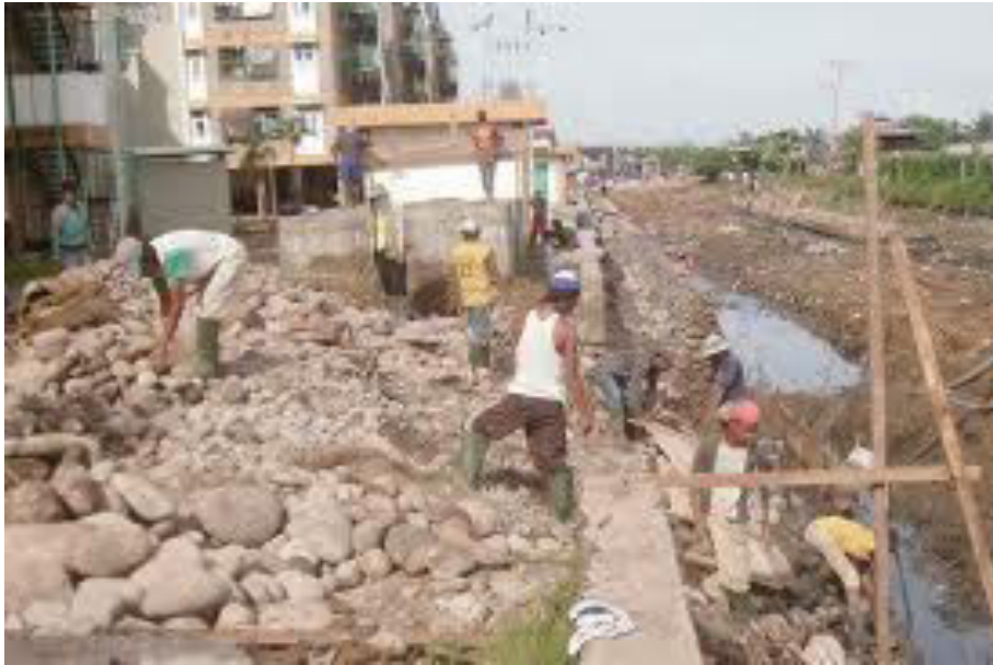
Gambar pemasangan batu kali 3.3
