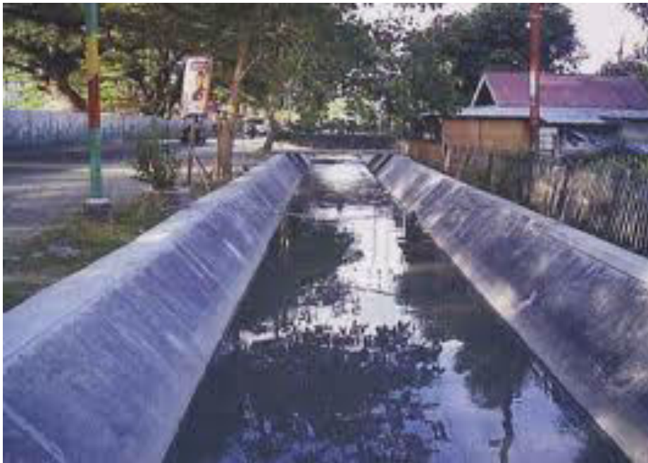
Pembangunan drainase selesai 4.4
