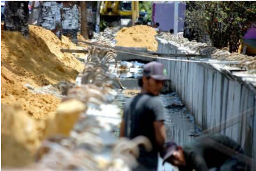
Gambar pelaksanaan pembangunan drainase jalan 1.1
