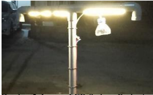
Gambar 5. Lampu LED Sedang Berkerja
