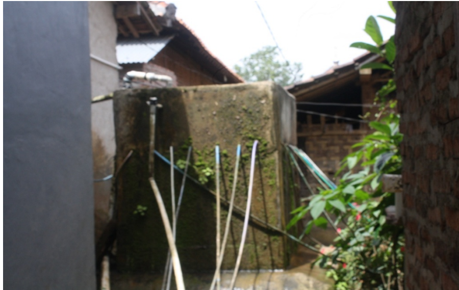
Gambar 7. Bak Penampungan air untuk dialirkan ke Rumah
