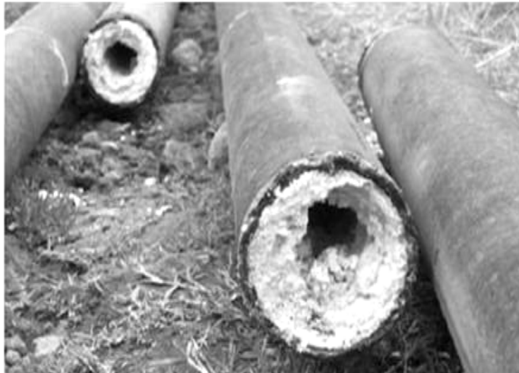
Gambar 3.2 Kerak pada Dinding Pipa PLTP Dieng (Sumber: Anonim, 2006)
