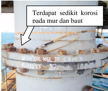
Gambar 14 Tampak dekat kondisi flange, baut, dan mur [8]
