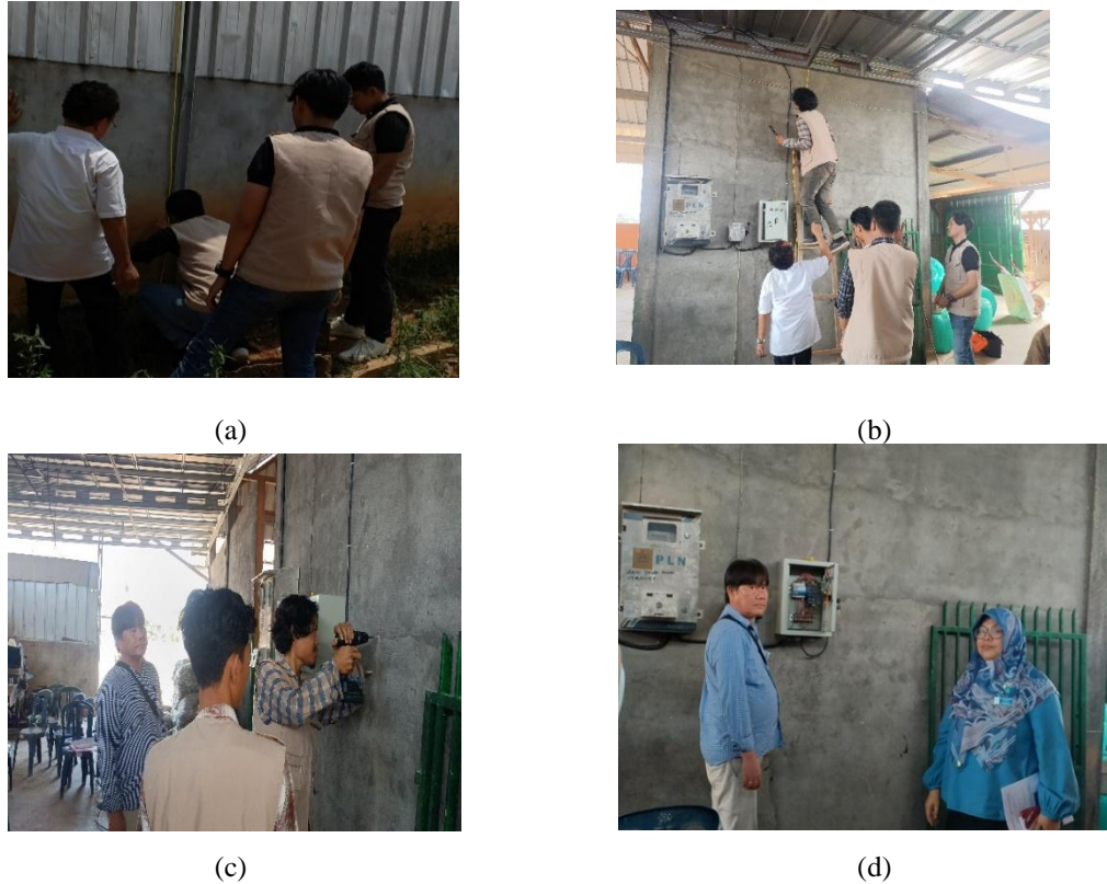
Gambar 7. Pelaksanaan Kegiatan : a. Pemasangan grounding oleh mahasiswa, b. Pemasangan down konduktor, c. Pemasangan panel untuk penempatan SPDs, d. Dosen peserta PKM didepan panel SPDs
