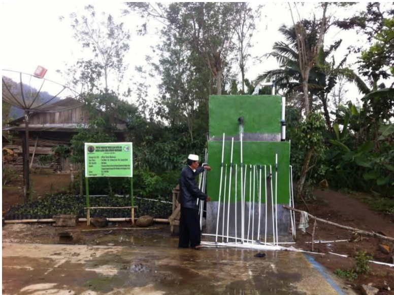
Gambar 2 Bak distribusi air bersih untuk masyarakat di Pekon Gedung Surian, Kecamatan Gedung Surian, Lampung Barat
