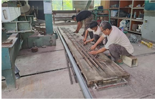
Gambar 23. Perakitan kerangka tangga ferosemen pracetak
