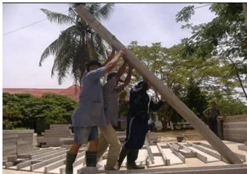
Gambar 3. Pendirian panel pertama bagian sudut rumah
