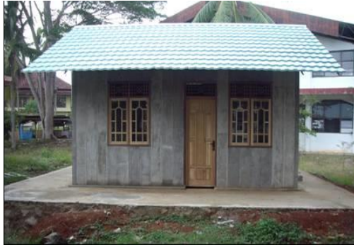
Gambar 7. Pemasangan daun jendela dan pintu
