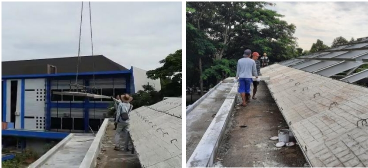
Gambar 21. Pengangkatan dan penyusunan panel ferosemen ke atap masjid
