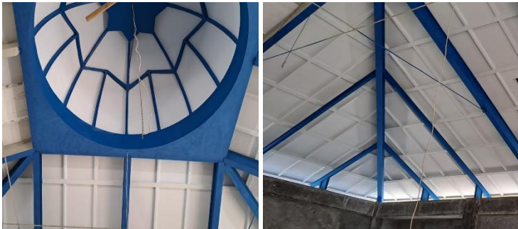
Gambar 22. Tampak bagian dalam atap masjid
