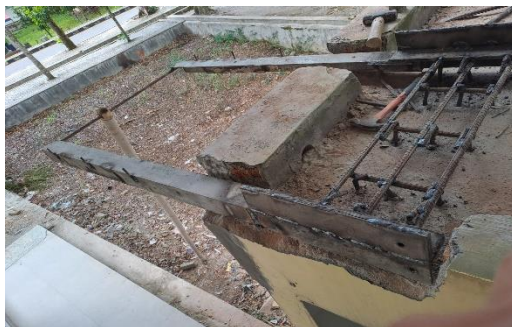
Gambar 25. Kerangka bordes pengait tangga
