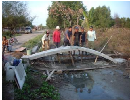
Gambar 16. Matras ferosemen untuk pondasi jembatan
