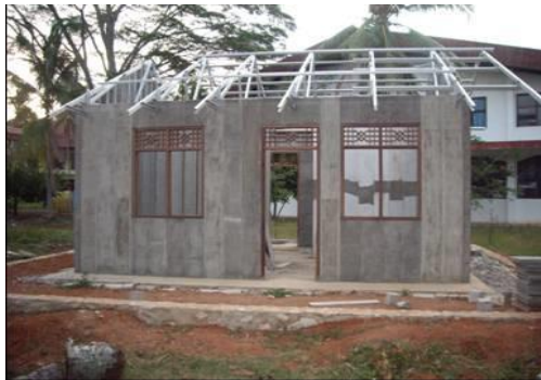
Gambar 6. Pemasangan kerangka atap
