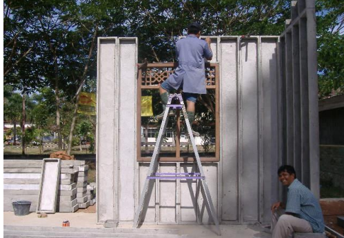
Gambar 4. Pemasangan kusen jendela
