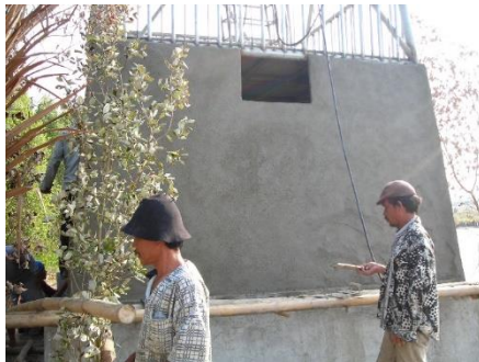
Gambar 33. Dinding fero semen untuk menara bagian bawah ( sumber Bayzoni)
