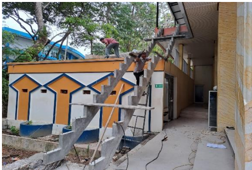
Gambar 27. Pemasangan balok tangga kedua
