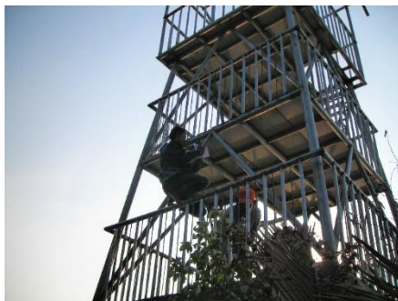
Gambar 34. Fero semen pracetak untuk lantai setiap tingkat ( sumber Bayzoni)
