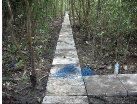
Gambar 15. Konstruksi jalan setapak di atas tanah lunak
