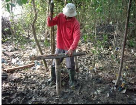
Gambar 12. Penancapan cerucuk bambu secara manual
