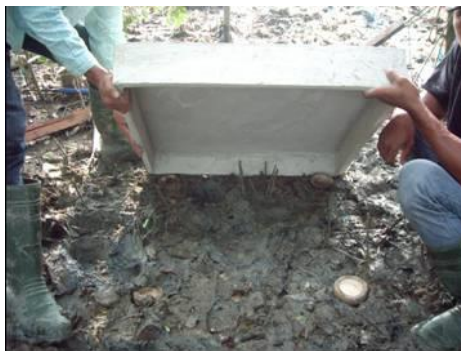
Gambar 14. Penempatan panel ferosemen
