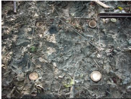
Gambar 13. Cerucuk bambu terpasang di 4 sudut
