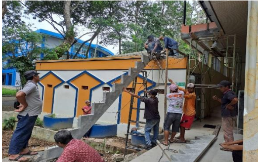
Gambar 26. Pemasangan balok tangga pertama
