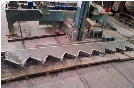
Gambar 24. Pabrikasi tangga ferosemen pracetak
