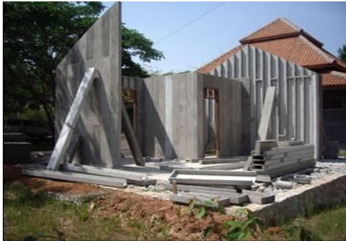
Gambar 5. Pendirian panel sisi gunung
