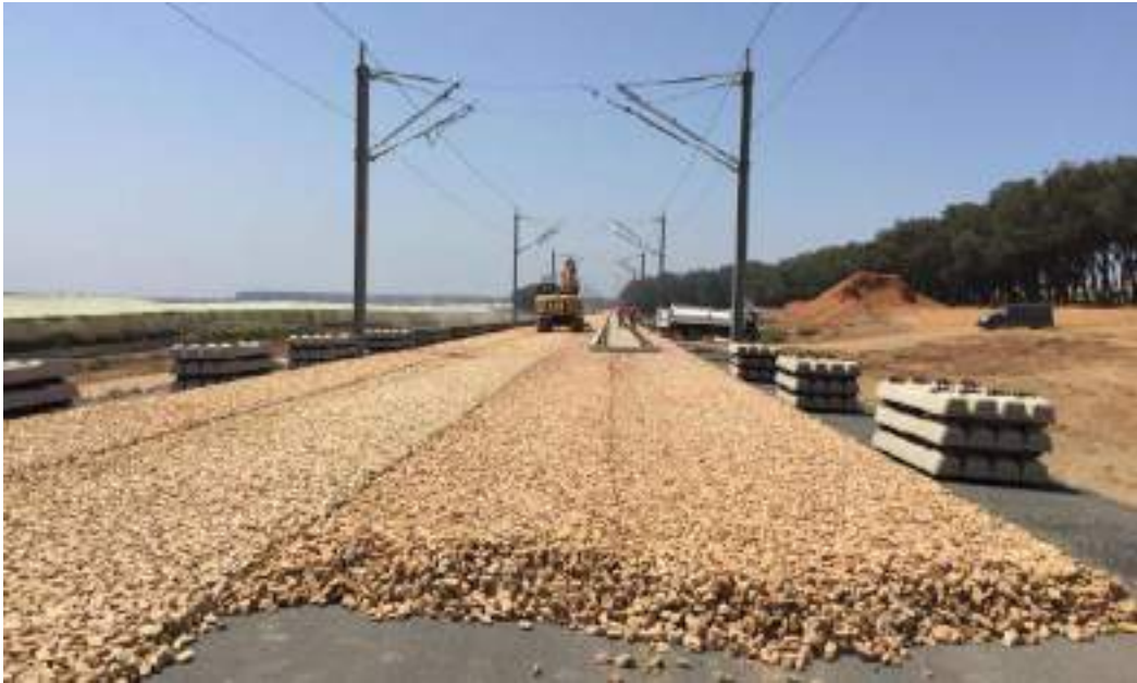
Gambar 3. 4 Al Boraq menghabiskan 4 metrik ton batu balas setiap meter track atau 1,6 juta ton untuk 186 km
