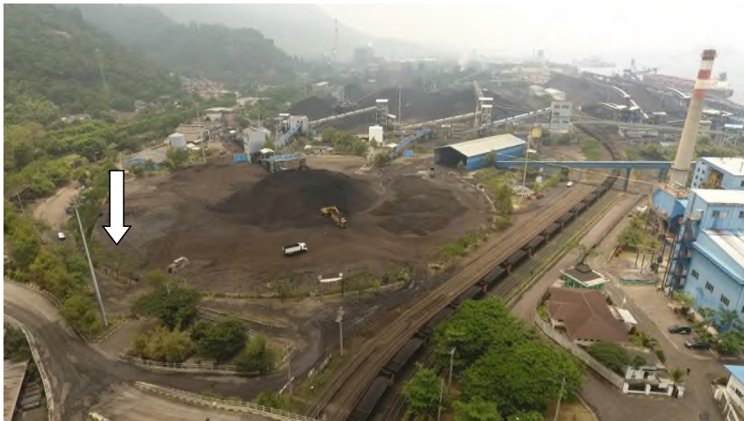
Gambar 3. Gambar Keadaan Drainase pada Stockpile .
