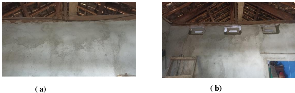
Gambar 4. Pemasangan ventilasi tembus (a) sebelum dipasang, dan (b) setelah dipasang ventilasi
