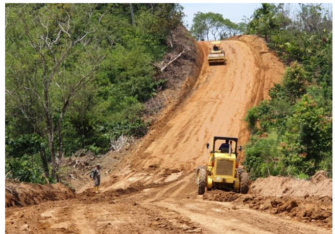
Gambar 3. Pelaksanaan Pekerjaan dilapangan
