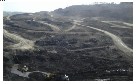
Gambar 3.9 Kondisi Jalan di Front Pasca Perbaikan
