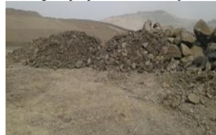
Gambar 3.8 Stok Material Perkerasan Badan Jalan
