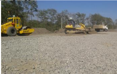
Gambar 3.4 Pemadatan Perkerasan Badan Jalan
