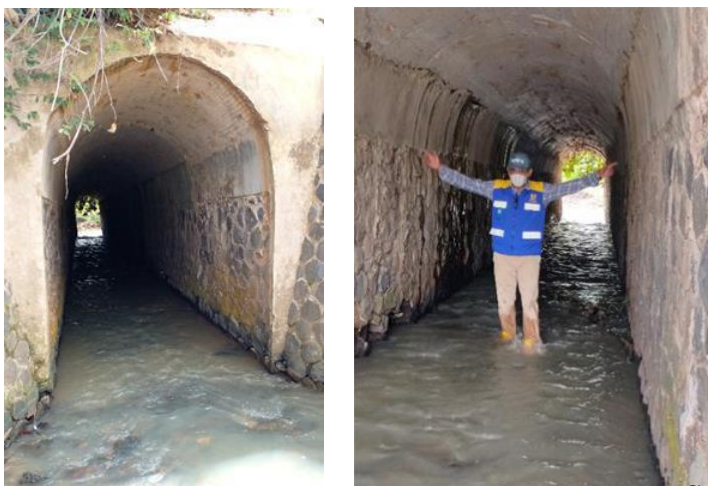
Gambar 4.3. Box Culvert Saluran Raman Utara Existing
