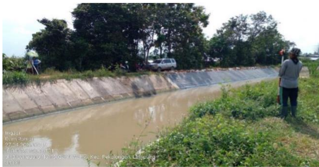
Gambar 4.2. Pelaksanaan Pengukuran Situasi Saluran Raman Utara
