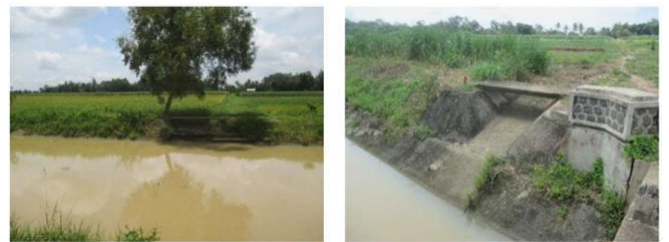
Gambar 4.3. Bangunan Drain Inlet
