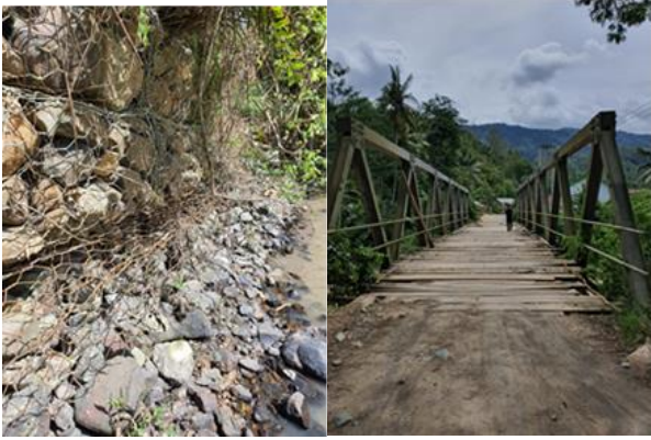
Gambar 3 Existing Bangunan Atas dan Bangunan Bawah Jembatan Way Semangka
