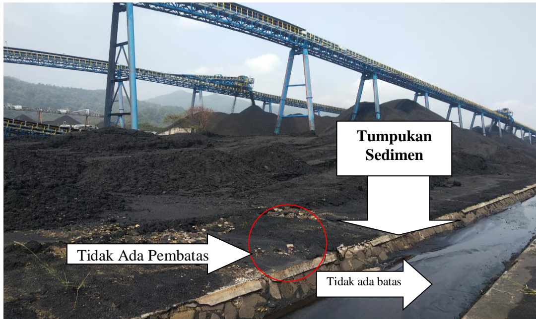
Gambar 2. Keadaan Saluran Drainase pada Stockpile yang Menuju ke KPL.
