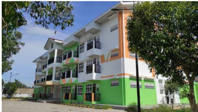
Gambar 16 RTH menjadi bangunan gedung rusunawa
