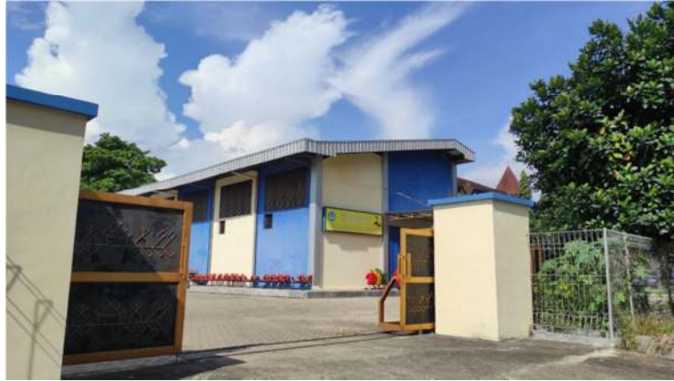
Gambar 15 RTH menjadi bangunan gedung TPST
