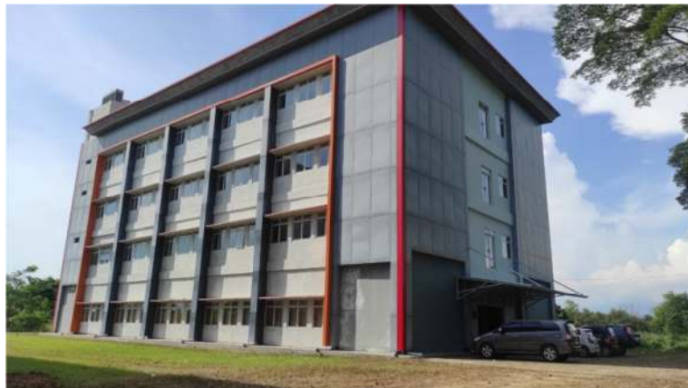
Gambar 19 Perubahan RTH menjadi bangunan gedung rumah sakit
