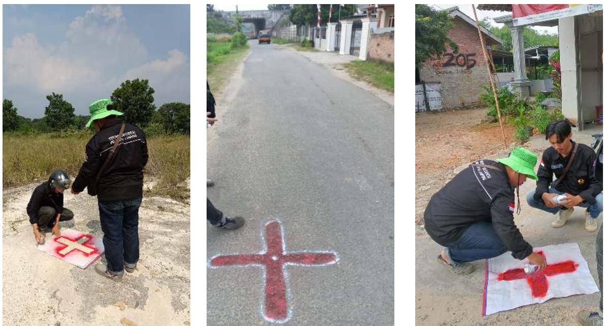
Gambar 3 Pemasangan GCP (a,b,c)
