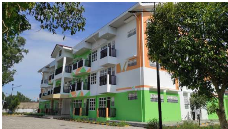
Gambar 16 RTH menjadi bangunan gedung rusunawa
