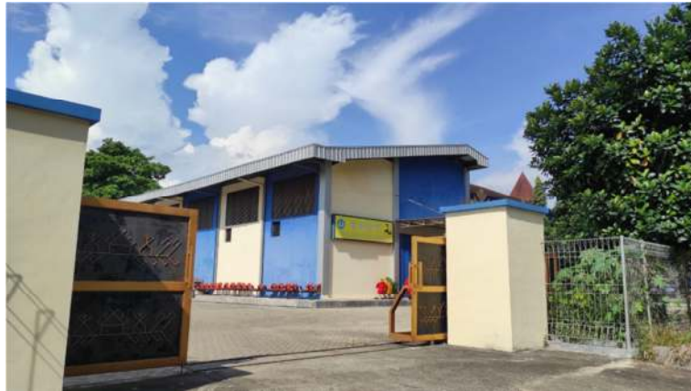
Gambar 15 RTH menjadi bangunan gedung TPST
