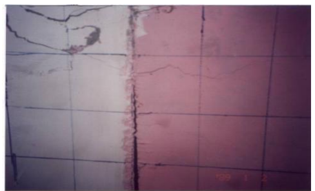
Gambar 8. Belahan pada batas sambungan
