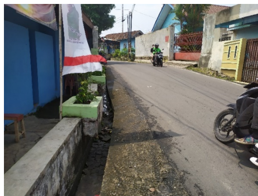
Gambar 5. Drainase jalan Mangkubumi.
