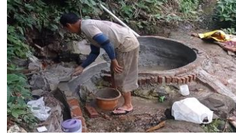
Gambar 3. Pembuatan bak penampungan air
