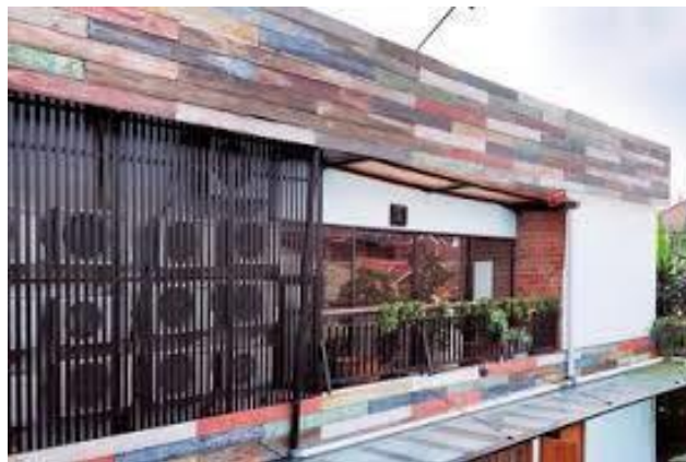
Gambar 8. Penggunaan kayu bekas kapal sebagai secondary skin Sumber: floolingdeckingbali.wordpress.com, 2020
