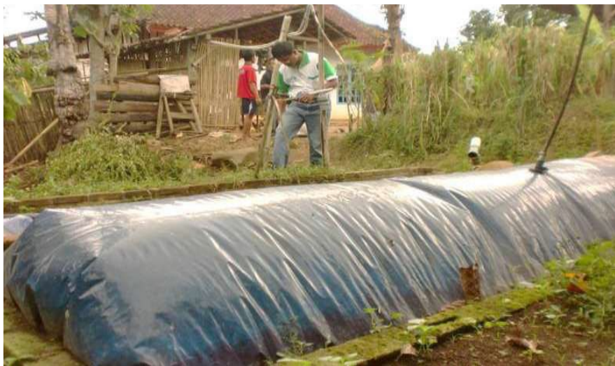
Gambar 3. Digester biogas tipe plastik tubuler (Foto: Agus Haryanto, 2011)
