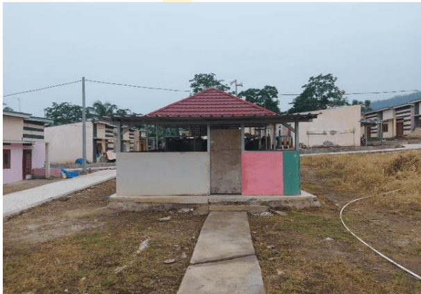
Gambar 1. Kondisi Masjid Darurat di Komplek Hunian Tetap Desa Kunjir
