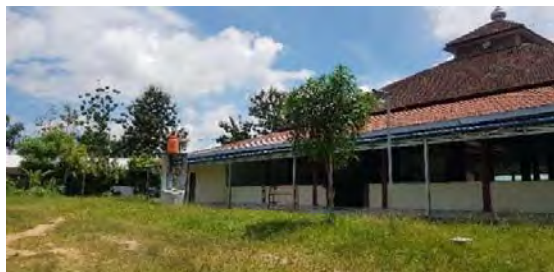
Gambar 3. Kondisi pada sisi kiri Masjid (Dokumentasi Survei)
