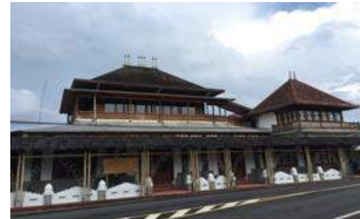
Dilindungi oleh Monumenten Ordonnantie Stbl. 238/1931 Sumber: Dokumentasi Pribadi
