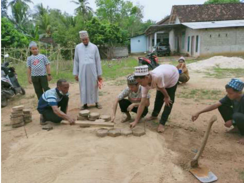
Gambar 11 Praktek pemasangan paving dengan memperhitungkan kemiringan dan kepadatan lahan,
