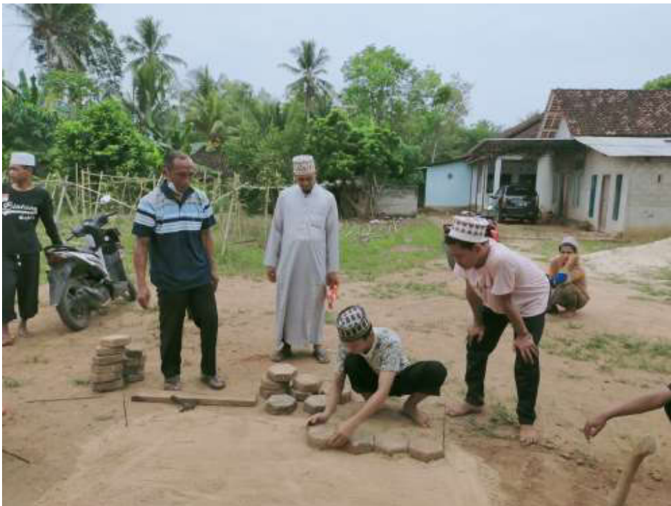
Gambar 12 Praktek pemasangan paving dengan ragam bentuk tertentu (segi enam/ hexagonal )
