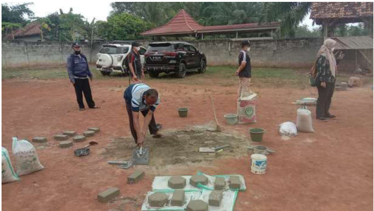
Gambar 9 Praktek pencampuran material paving blok
