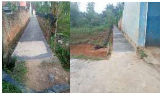
Gambar 12. Jalan menuju Asrama Putra yang sudah dipaving
