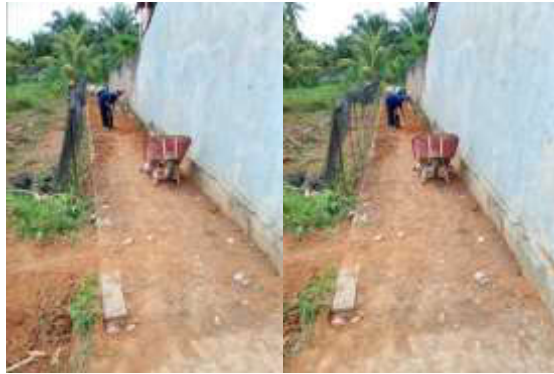
Gambar 11. Jalan menuju Asrama Putra yang sedang disiapkan untuk dipaving
