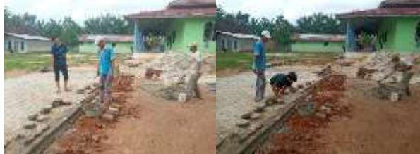
Gambar 13. Pemasangan paving blok di depan asrama putra
