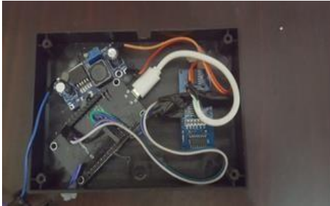
Gbr.7 Proses Instalasi Perangkat
