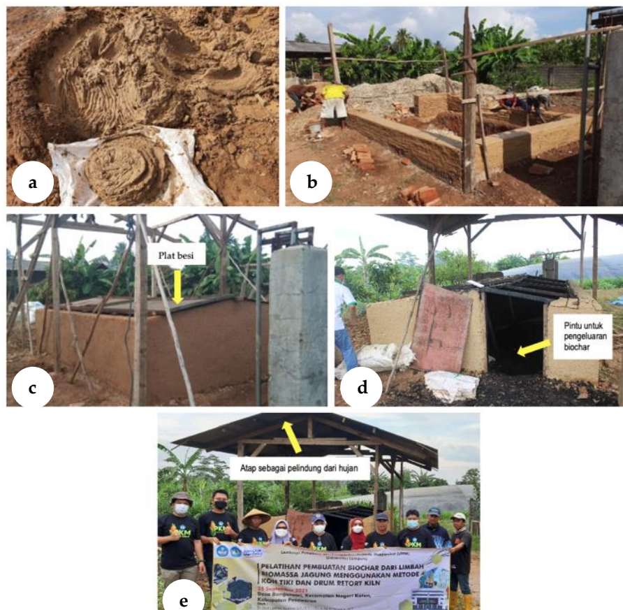
Gambar 3. Proses Pembuatan Tungku Biochar: (a) Tanah Liat sebagai Pelapis Dinding, (b) Konstruksi Dinding Tungku, (c) Tungku Dilengkapi Plat Besi untuk Pemasukan Bahan Baku, (d) Pintu untuk Pengeluaran Biochar, dan (e) Atap sebagai Pelindung dari Hujan.
