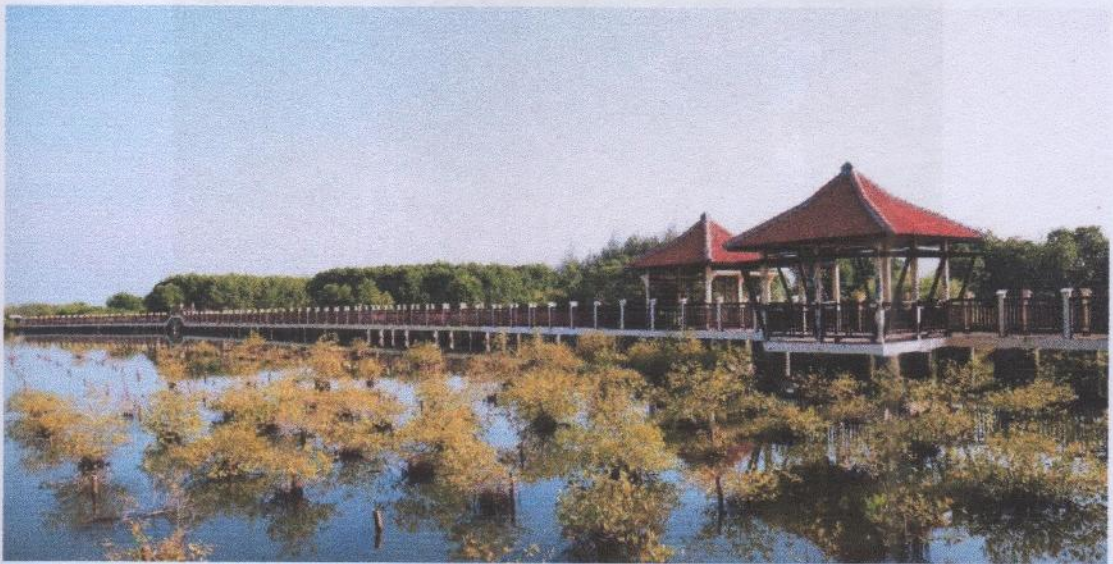
Gambar 4.19 Contoh akses jalan pada hutan mangrove dengan tiang pancang terbuat dari cor beton.
