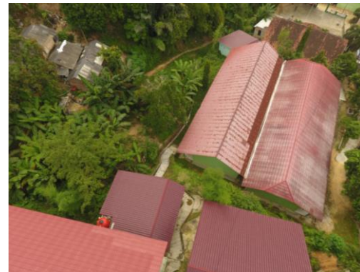
Gambar 5. Foto udara kondisi SMAN 17 Bandar Lampung yang berada di topografi tinggi.
