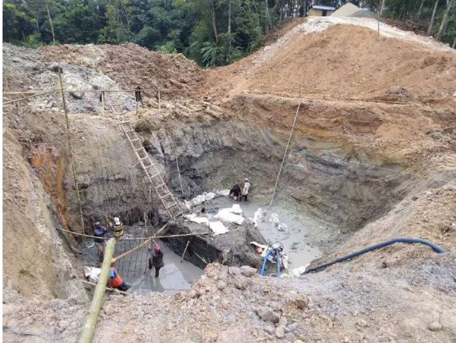
Gambar 10. Pembangunan jembatan oleh pemerintah Kota Metro.
