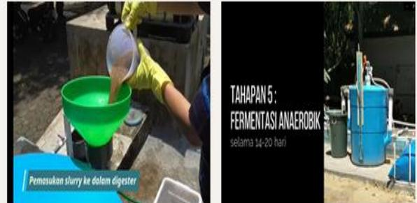
Pemasukan slurry ke dalam digester
