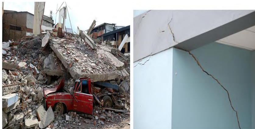
Gambar 4. Kerusakan bangunan akibat efek getaran
