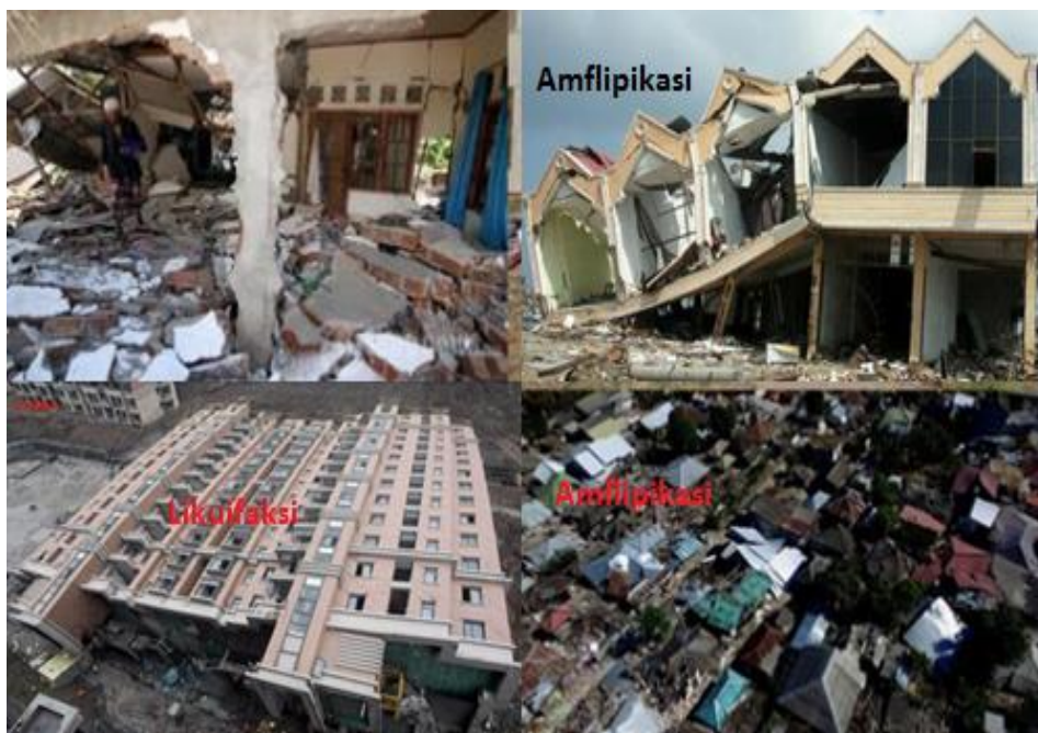
Gambar 2. Efek amplifikasi getaran lapisan tanah pada bangunan
