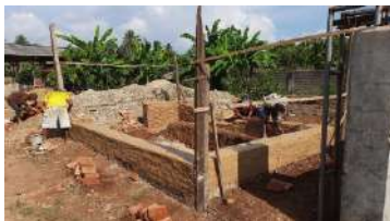
Gambar 9. Proses pembuatan tungku pirolisis.
