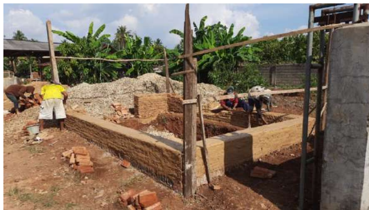
Gambar 10. Proses pembuatan tungku pirolisis.
