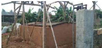
Gambar 10. Tungku pirolisis dengan metode tungku yang dimodifikasi.
