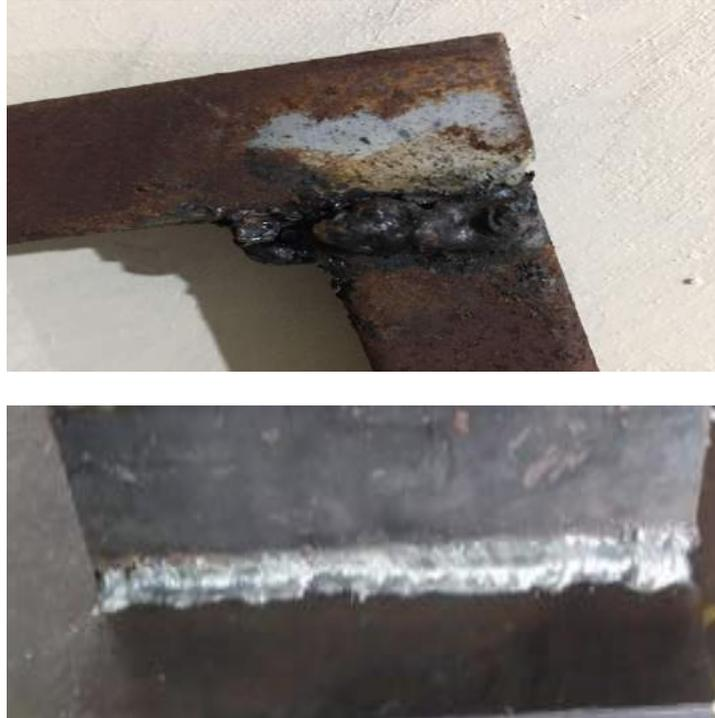
Gambar 3. Perbaikan Teknik pengelasan
