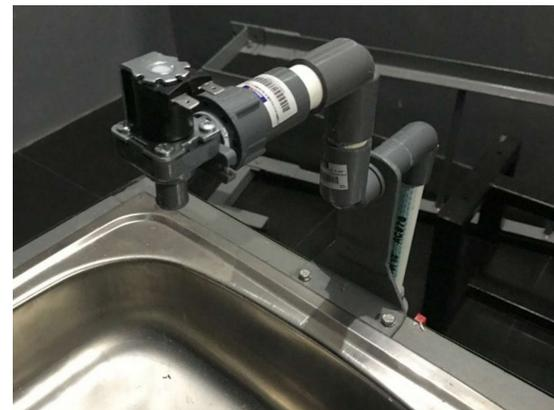
**Gambar 14.** Selenoid katup otomatis
