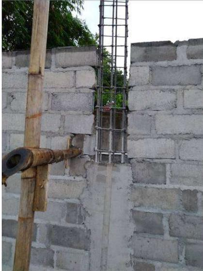
**Gambar 4.** Pemasangan dinding dan Kolom.
