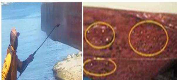
**Gambar 8.** Pembersihan zona lambung fiberglass
