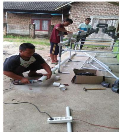
Gambar 5. Perakitan Instalasi Hidroponik.
