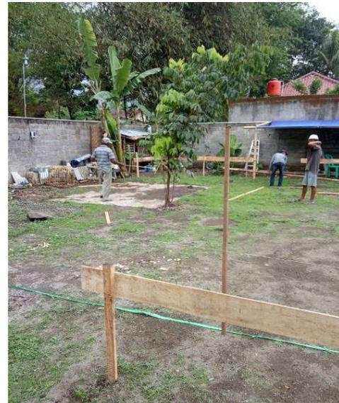
**Gambar 3.** Pengukuran dan Pemasangan Bowplank.
