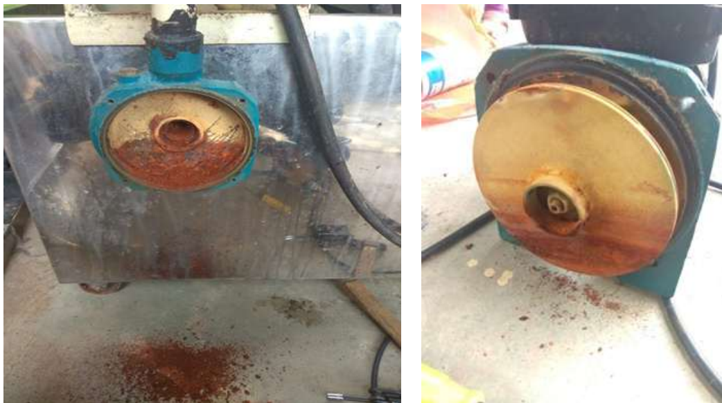
Gambar 4. Karat pada pompa dan sistem vakum
