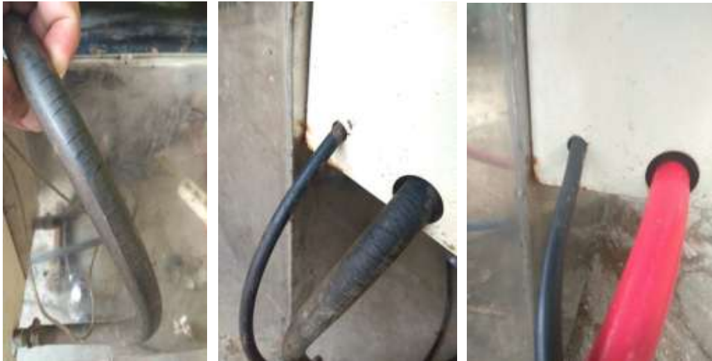
Gambar 6. Kondisi selang gas sebelum perbaikan dan penggantian selang gas setelah perbaikan.
