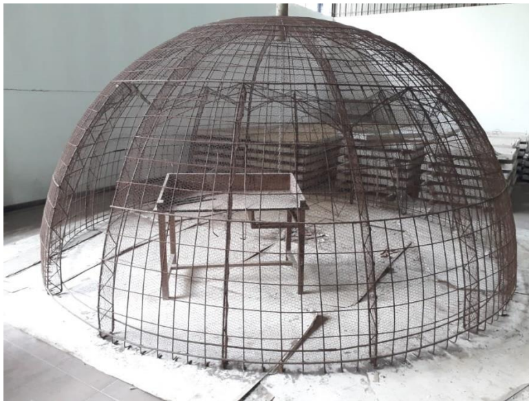
Gambar 34. Kerangka kubah ferosemen yang siap dipasang
