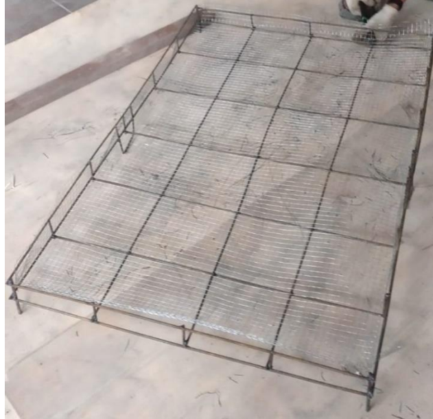
Gambar 32. Kerangka panel ferosemen.
