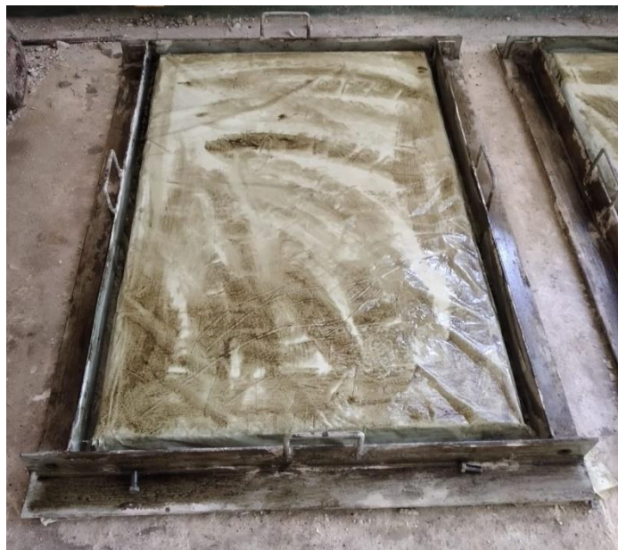
Gambar 32. Cetakan panel ferosemen
