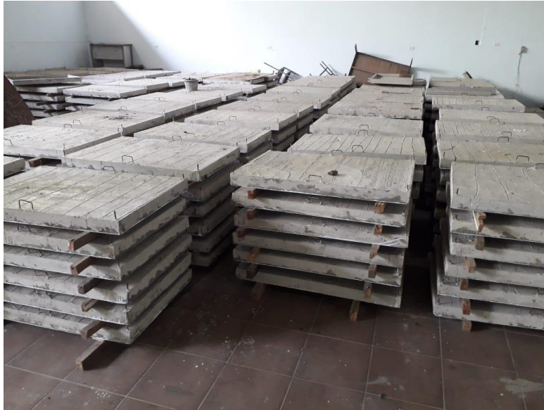
Gambar 34. Panel ferosemen yang siap dipasang
