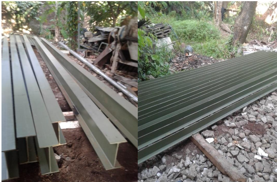
Gambar 35. Kerangka atap baja IWF dan gording
