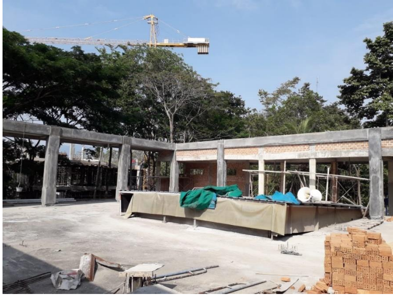
Gambar 34. Struktur ringbalok tempat dudukan rangkan baja IWF
