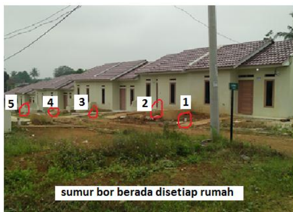
Gambar 1. Sumur Bor yang Dibangun disetiap Rumah
