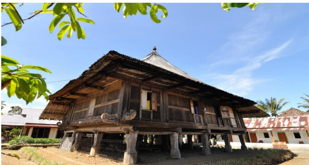
Gambar 9. Lamban Pesagi. Sumber: Dokumentasi Pribadi.
