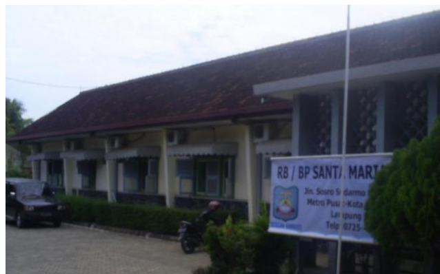
Gambar 6. Bangunan RB Santa Maria di Kota Metro.
