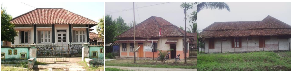
Gambar 5. Bangunan Peninggalan Perjuangan Kemerdekaan Indonesia di Kota Lama Menggala.
