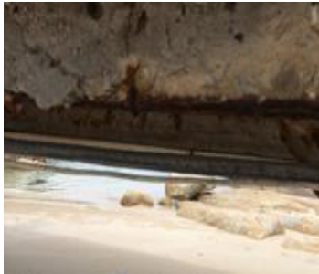
Gambar 1.14. Kerusakan karena selimut beton yang tidak sesuai, (a) lantai beton, (b) balok, (c) balok di pantai, (d) kehancuran total
