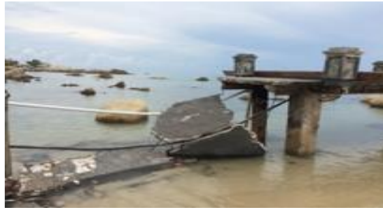
Gambar 1.14. Kerusakan karena selimut beton yang tidak sesuai, (a) lantai beton, (b) balok, (c) balok di pantai, (d) kehancuran total
