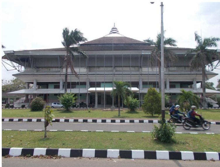
Gambar IV. 2 Eksisting Gedung Serbaguna (GSG) Unila
