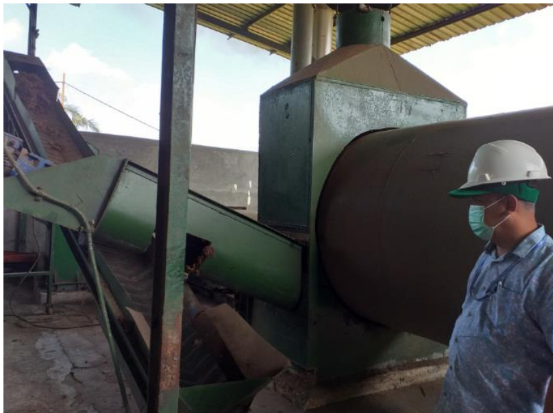
Gambar 5-3. Rotary dryer untuk mengeringkan TKKS di PT. THS
