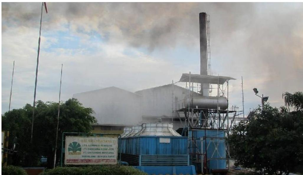
Gambar 5. Pembangkit Listrik Tenaga Uap Listrindo Kencana (Bangka) menggunakan bahan bakar limbah padat kelapa sawit (cangkang, fiber, dan janjang kosong).
